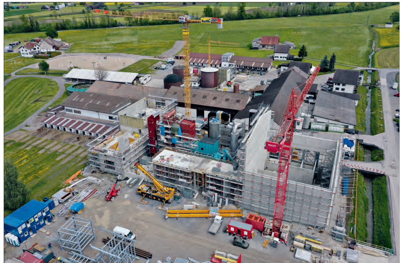
Im Dezember 2019 wurden die Verträge unterzeichnet, 2020 fand der Spatenstich statt (hier ein Bild aus der Bauphase) und Mitte dieses Jahres lieferte das Altholz-HKW erstmals Strom und Wärme. Fotos: Polytechnik
