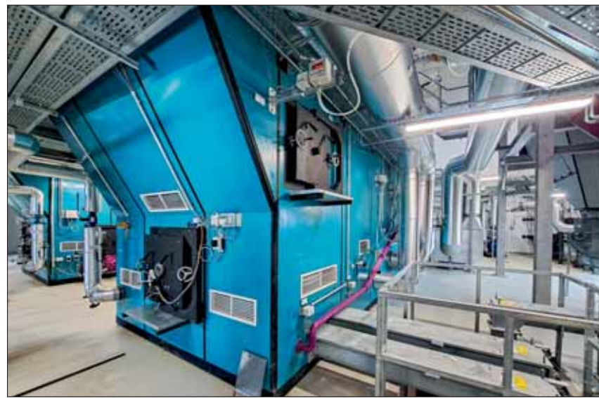
Blick auf die Vorschubrostfeuerungen des Warmwasserheizwerks der Stadtwerke Kaposvar: Die beiden 7,5 MW-Heißwasserkessel von Polytechnik versorgen über 7200 Wohnungen und Gebäude mit Wärme aus Holzbiomasse.
