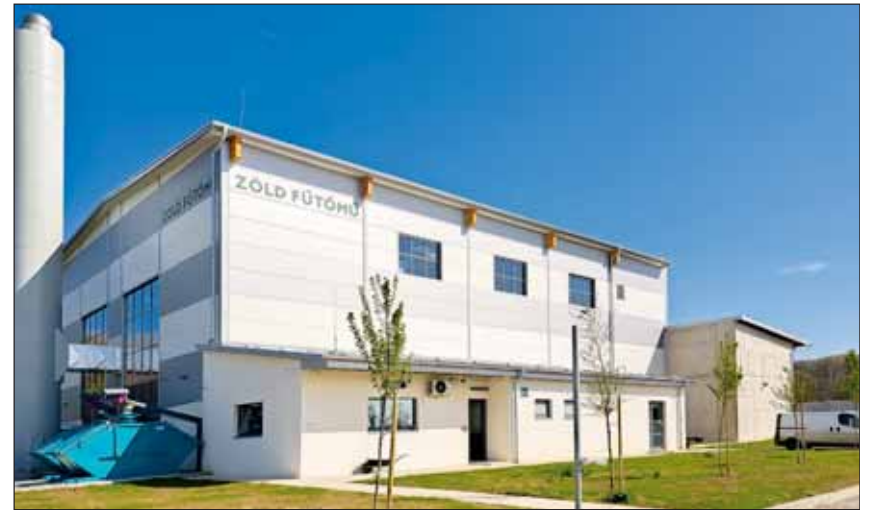
In der ungarischen Region Südtransdanubien nahmen die Stadtwerke Kaposvar mit der 15 MW-Heizzentrale von Polytechnik eine nachhaltige Energielösung in Betrieb. Fotos: Polytechnik
