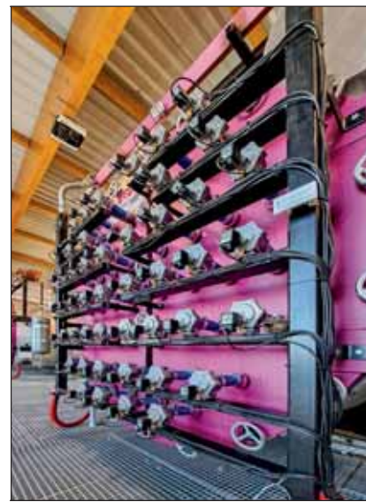
Blick auf die Vorschubrostfeuerungen des Warmwasserheizwerks der Stadtwerke Kaposvar: Die beiden 7,5 MW-Heißwasserkessel von Polytechnik versorgen über 7200 Wohnungen und Gebäude mit Wärme aus Holzbiomasse.
