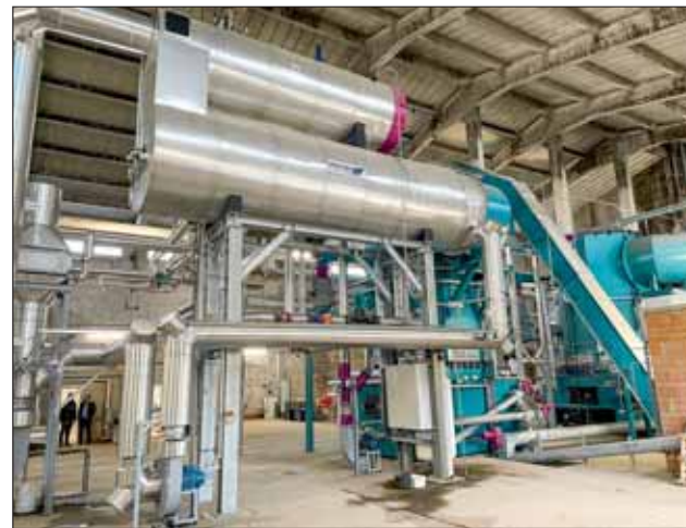
Blick auf die in der Gärtnerei Knap installierte 2 x 2000 kW-Holzvergaseranlage vom Typ „Polyheld“
