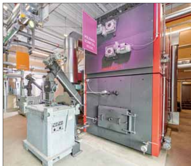
Anlagenbeispiel: Vorschubrostfeuerung mit 875 kW und Feinstaubfilter
