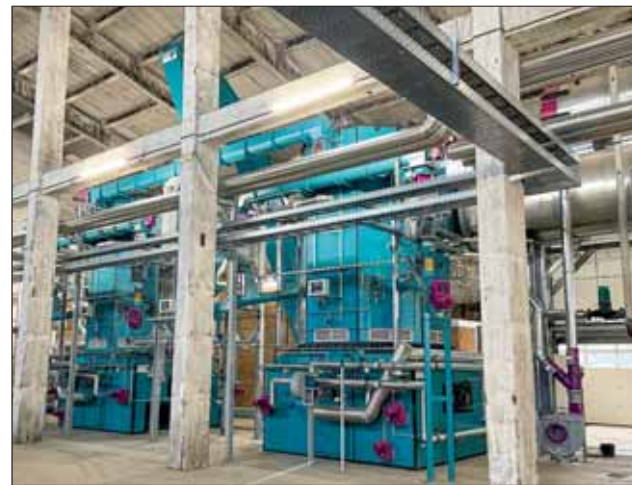
Blick auf die in der Gärtnerei Knap installierte 2 x 2000 kW-Holzvergaseranlage vom Typ „Polyheld“
