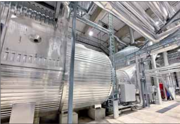
Polytechnik hat wichtige Komponenten beigesteuert, wie Brennkammer, Kessel, Heißwassersystem einschließlich Steuerung.
